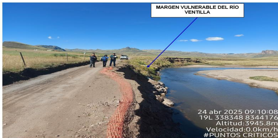
FIGURA N°02: ZONAS PROPENSAS ANTE UNA CRECIDA DEL RÍO VENTILLA Y LA EROSION EN LA MARGEN DONDE SE EVIDENCIA RIESGO DE COLAPSO DE LA PRINCIPAL VIA TROCHA CARROZABLE
